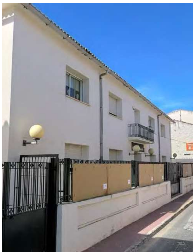
Edificio el Puig
