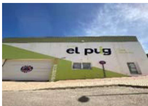
Edificio el Puig
